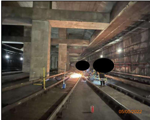
รูปที่ 2-5 การตรวจสอบและซ่อมบำรุงรางรถไฟฟ้าอย่างสม่ำเสมอ
