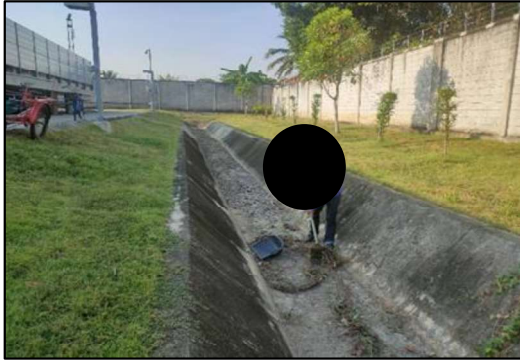
รูปที่ 2-20 การตรวจสอบ ดูแล และขุดลอกที่ระบายน้ำและบ่อกักที่ระบายน้ำอย่างสม่ำเสมอ ภายในพื้นที่ศูนย์ซ่อมบำรุง
