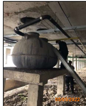
รูปที่ 2-21 ระบบบำบัดน้ำเสียภายในศูนย์ซ่อมบำรุง
